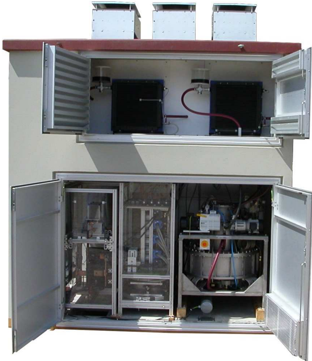
Abbildung 6 : Betoncontainer mit Energiespeicher
