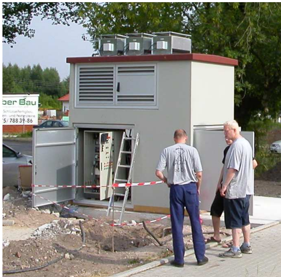
Abb. 5 Inbetriebnahme des Schwungradspeichersystems in Zwickau am 15.08.06
